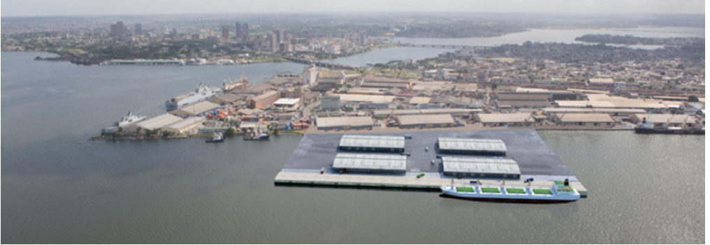
Photo : PAA / Création d'un terminal céréalier (Démarrage des travaux janvier 2020) – Après travaux
